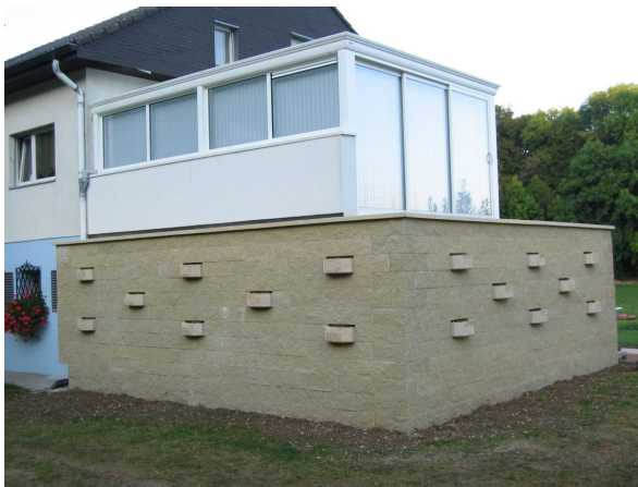
Côté route et poste
